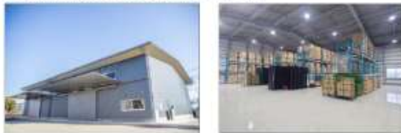
防災備蓄倉庫外観および内観(鶴沼朝日町)
